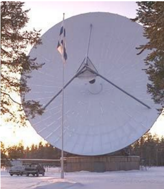
Kuva 6.22. EISCAT -järjestelmään kuuluva ionosfääritutkan vastaanottoantenni Sodankylän geofysiikan observatoriossa. Peilin halkaisija on noin 30 m. Yhdessä kahden muun antennin (Tromssa ja Kiiruna) kanssa synkronissa saadaan elektronien kolmiulotteinen liike selville heijastuskohdassa monen muun ionosfäärin avaruussäätötilaa luonnehtivan fysikaalisen suuren lisäksi. (Kuva: SGO ).
